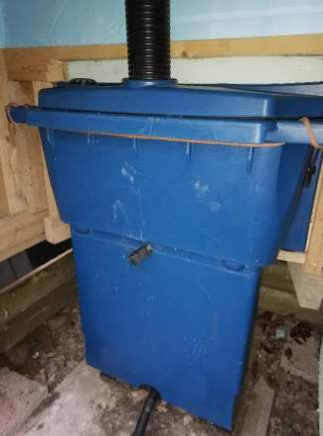
Kuvat 5 ja 6. Biolanin Populett -erotteleva käymälä käytössä asennettuna ja tyhjänä (kuvat: Sari Huuhtanen).
