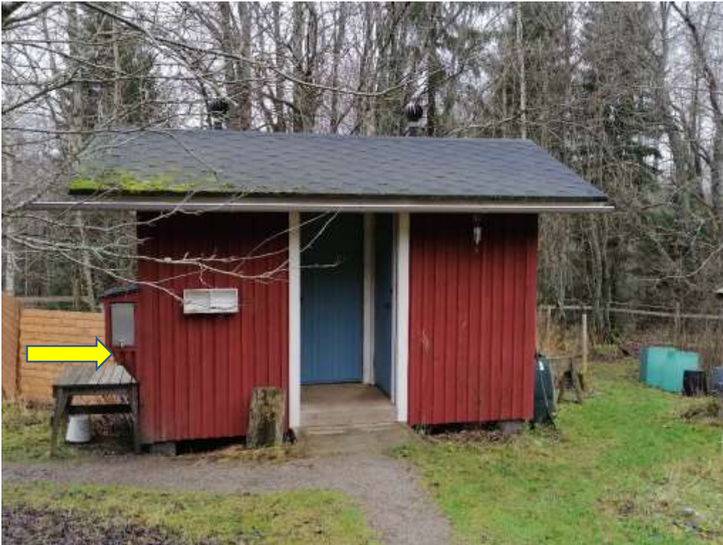
Kuva 2. Käymälärakennus edestäpäin (kuva: Sari Huuhtanen). Käymälät ovat rakennuksessa oikealla ja vasemmalla puolella. Käsienpesupiste näkyy kuvassa vasemmalla (keltainen nuoli).
