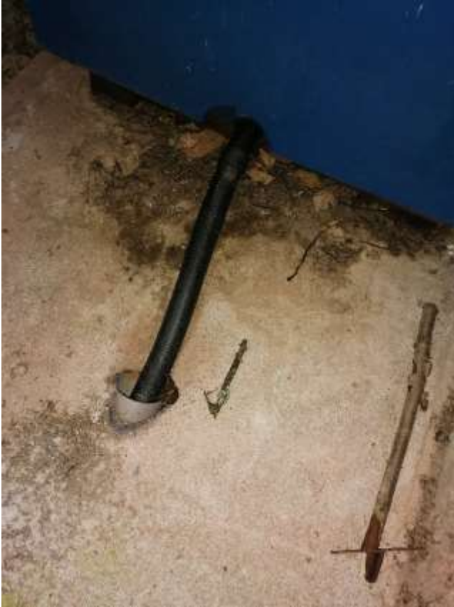
Kuva 12. Eroteltu virtsa johdetaan umpisäiliöön (kuva: Sari Huuhtanen).
