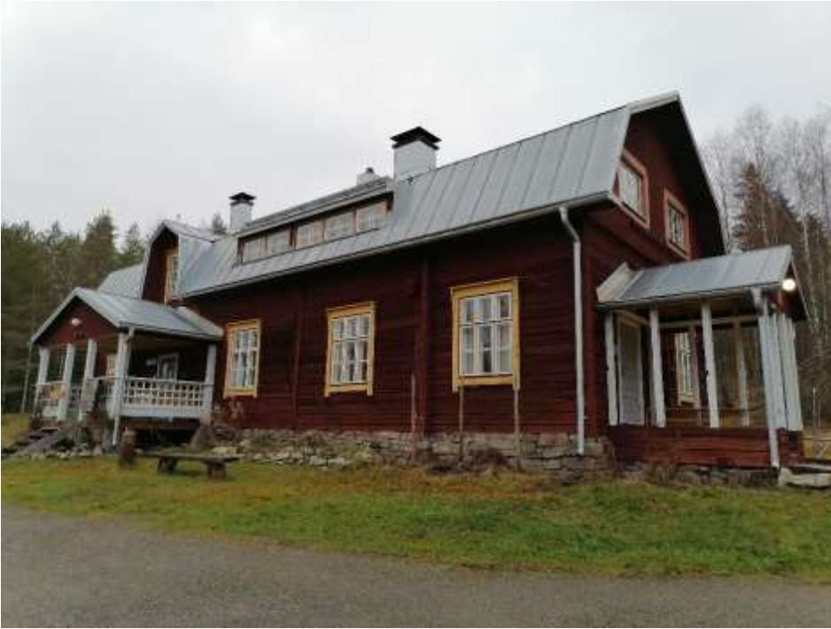
Kuva 1. Kolin Keitaan päärakennus (kuva: Sari Huuhtanen).
