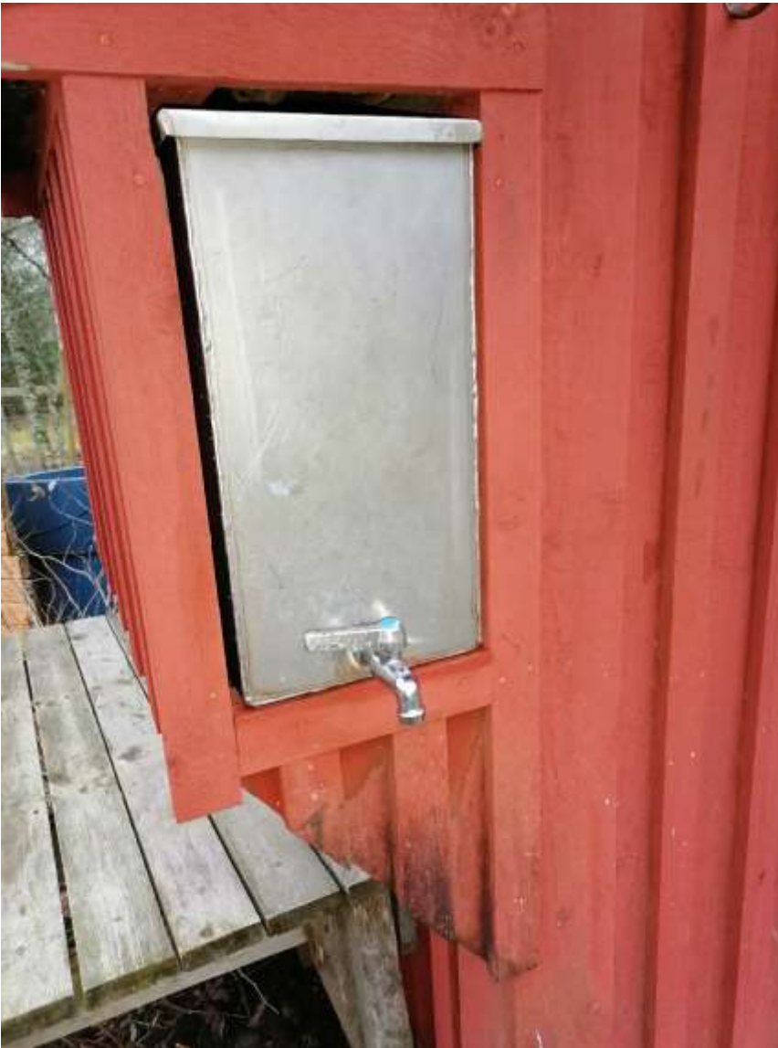
Kuva 4. Käsienvpesupiste käymälän ulkopuolella (kuva: Sari Huuhtanen).
